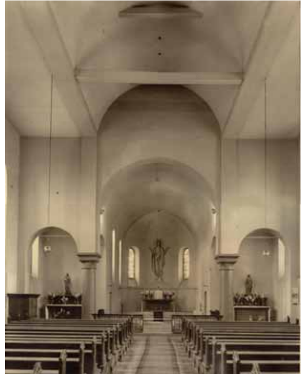
Bild 8: Kirche nach der Innenrenovierung 1949
