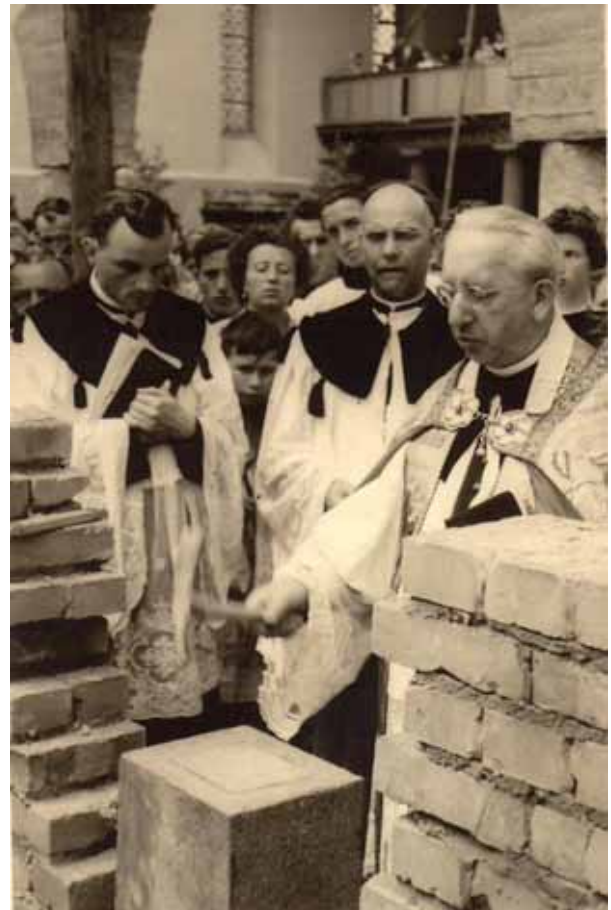
Bild 12: Grundsteinlegung zum Erweiterungsbau durch Geistlichen Rat Direktor Weißbäcker; links von ihm Pfarrer Schmitt, daneben Kaplan Alban.
