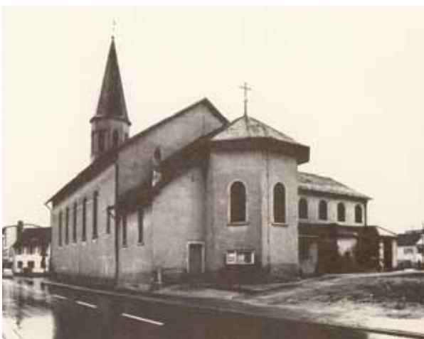
Bild 14: Außenansicht der Kirche nach der Erweiterung 1956, von Eppertshausen her gesehen. Man erkennt deutlich das neu angesetzte Hauptschiff mit dem Windfang des hinteren Seiteneingangs. Der heutige Gallusplatz ist noch im Rohzustand.
