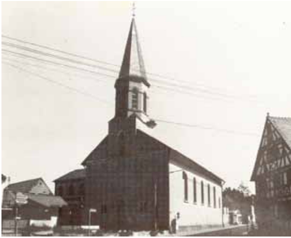
Bild 13: Die Kirche von außen, nach der Erweiterung von 1956. Links sieht man die letzten drei Fenster des neu angebauten Hauptschiffes
