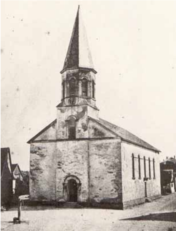
Bild 2: Die Kirche im Jahr 1856. Sie hat bereits den Spitzhelm, der das ursprünglich niedrige Kuppeldach ersetzt. An der Straßenseite ist noch ein Seiteneingang zu erkennen, die kleinen Fenster rechts und links vom Turm fehlen noch. Auf dem "Dalles" steht noch die Schwengelpumpe des Brunnens, damals Wasserversorgung für die Nachbarschaft.
